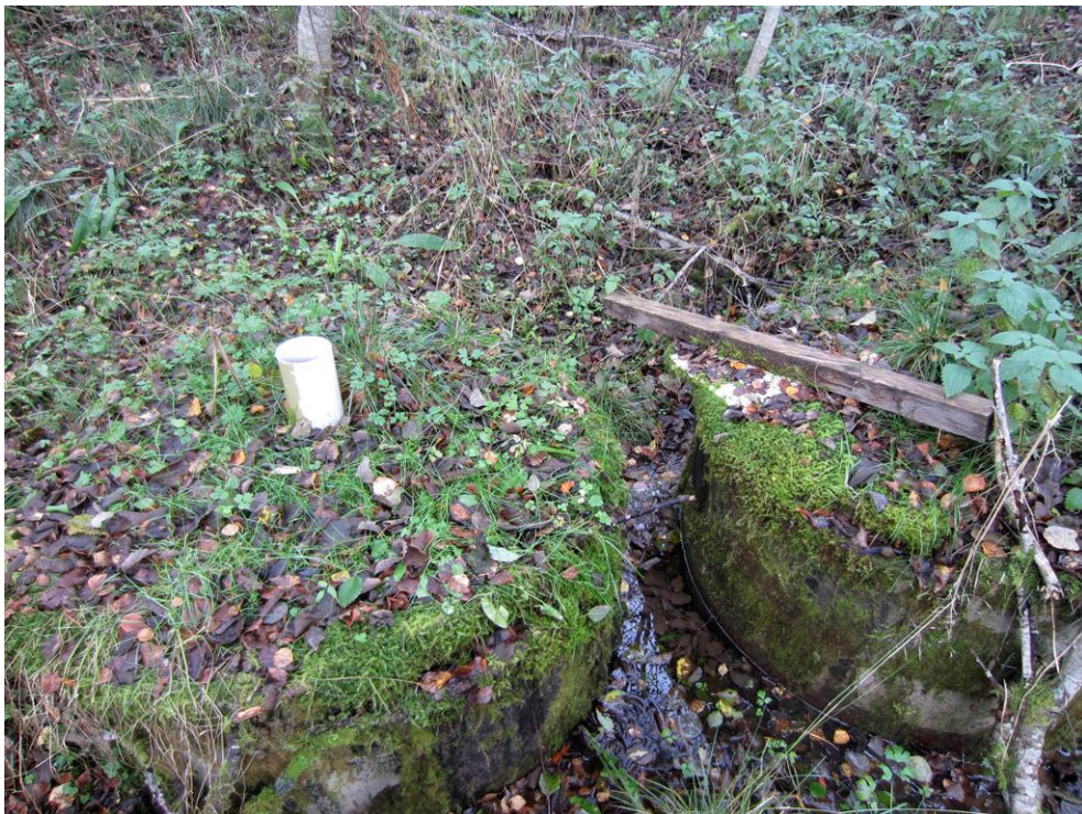
Kuva 3-3. Lähteeseen on upotettu kaivonrenkaat (kuvassa alhaalla). Yläkuvassa lähteen ylivirtaaman muodostama noro.
